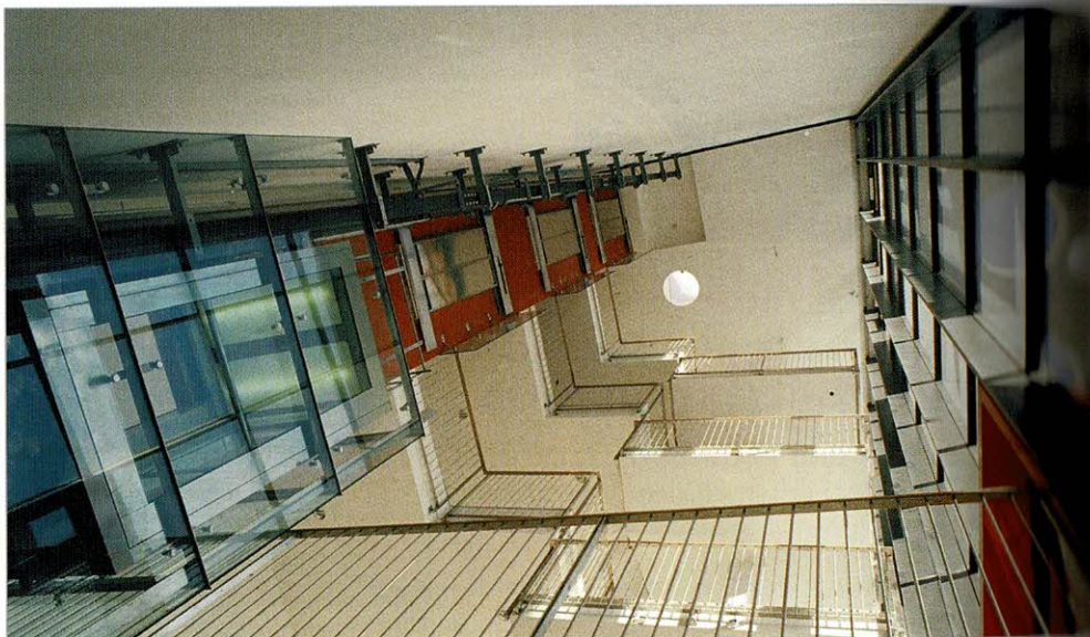
Baucenter Bozen – Stiegenhaus
